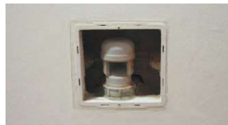
Obr. 4 Přivzdušňovací ventil pro připojovací potrubí umístěný ve výklenku ve stěně
