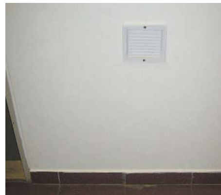
Obr. 5 Demontovatelná mřížka zakrývající výklenek s přivzdušňovacím ventilem
